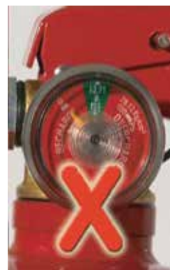
รูปที่ 2 เข็มอยู่ในช่องพื้นที่ "สีแดง" ด้านซ้ายหรือขวา แสดงว่า "เครื่องดับเพลิงอยู่ในสภาวะผิดปกติ" ต้องรีบทำการบรรจุน้ำยาดับเพลิงใหม่ทันที
